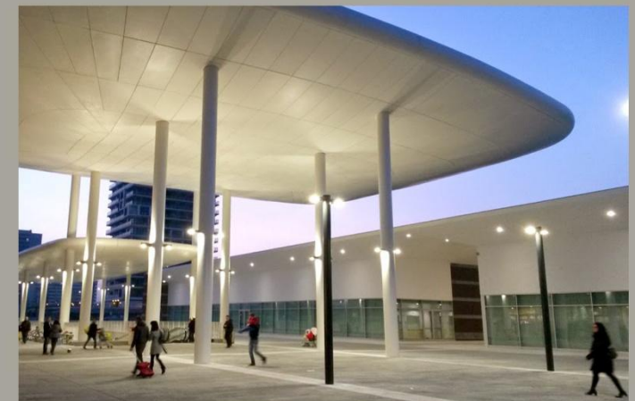
DLC, Edificio commerciale P.I.I. Adriano Marelli, Milano
