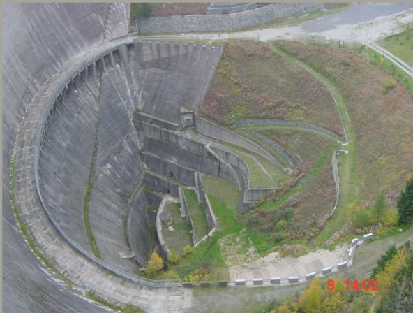
Studio Marcello, Intervento di recupero diga Beauregard
